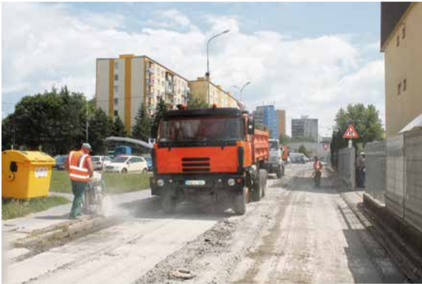
Megarekonštrukcia mestských komunikácií sa rozbehla v júni...
