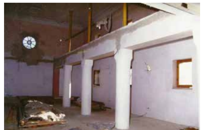
Stav interiéru počas prestavby v r. 1993-1995
